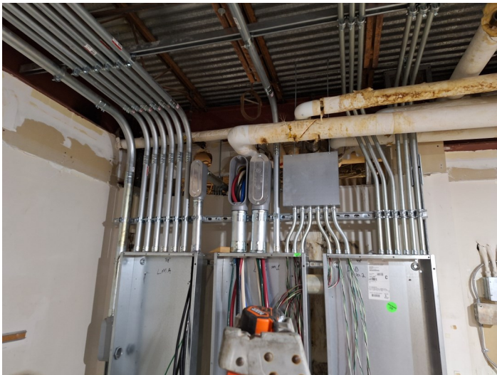
Installing new electrical conduit
